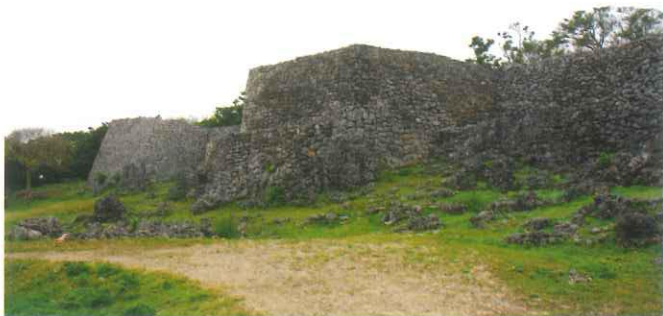
写真手前の突出部が南の虎口跡、奥が南のアザナです。
